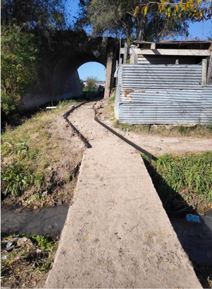
FOTOGRAFÍA 10. Vereda en construcción uniendo Puente de Fierro y Barrio Evita
