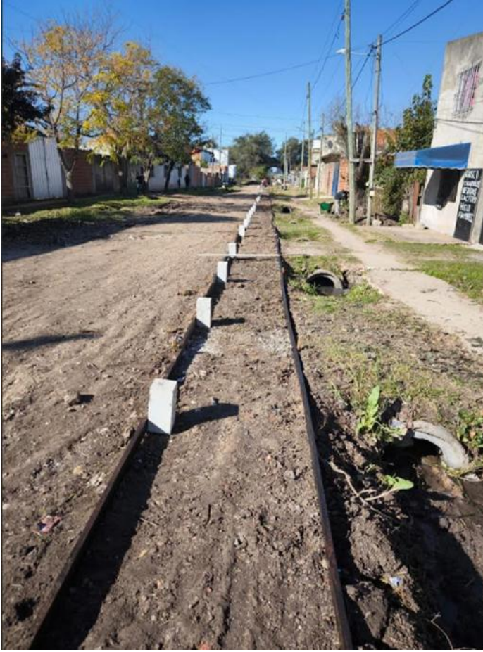
FOTOGRAFÍA 8. Preparación de encofrados y pilares
